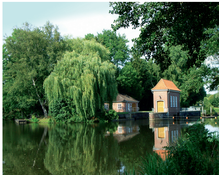
Das Oste-Wehr in Bremervörde
